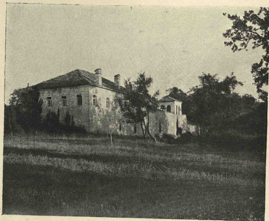
Mănăstirea Zița, vedere exterioară
