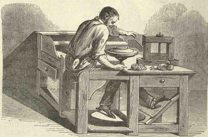
Fig. 82. Façonnage d'une assiette sur le tour avec le gabarit .
